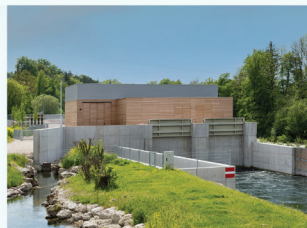
Wasserkraftwerk Stadl-Paura (Traun)
