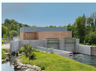
Wasserkraftwerk Stadl-Paura (Traun)
